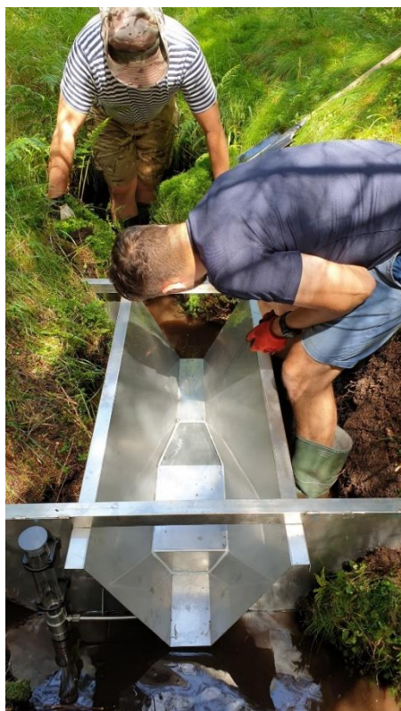
Obr. 1. Instalace a vyrovnání žlabu
