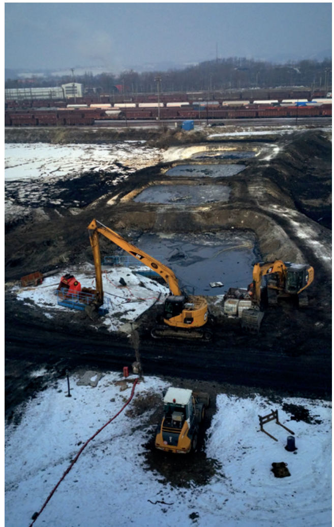
Obr. 2 Laguny Ostramo v době sanačních prací (autor: R. Štěrbá, 2018).
