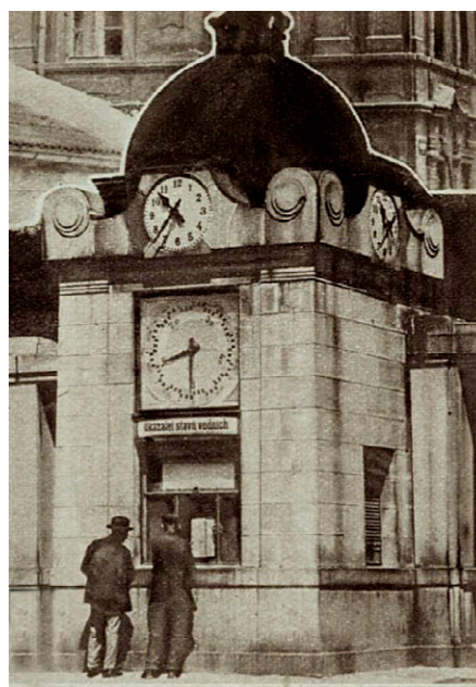
Obr. 20 Pozoruhodná fotografická momentka zachycující někdy před rokem 1928 dvě osoby, jak nahlížejí do velkého okna limnigrafu Na Františku. Měly možnost se tak seznámit s meteorologickými údaji a vodním stavem Vltavy. Na pásce z limnigrafu pod nápisem „ukazatel stavů vodních“ sledovaly průběh výšky hladiny řeky za uplynulý týden. Zdroj: Letem světem obrázkový týdeník II, č. 46, 4. 9. 1928, s. 10.
