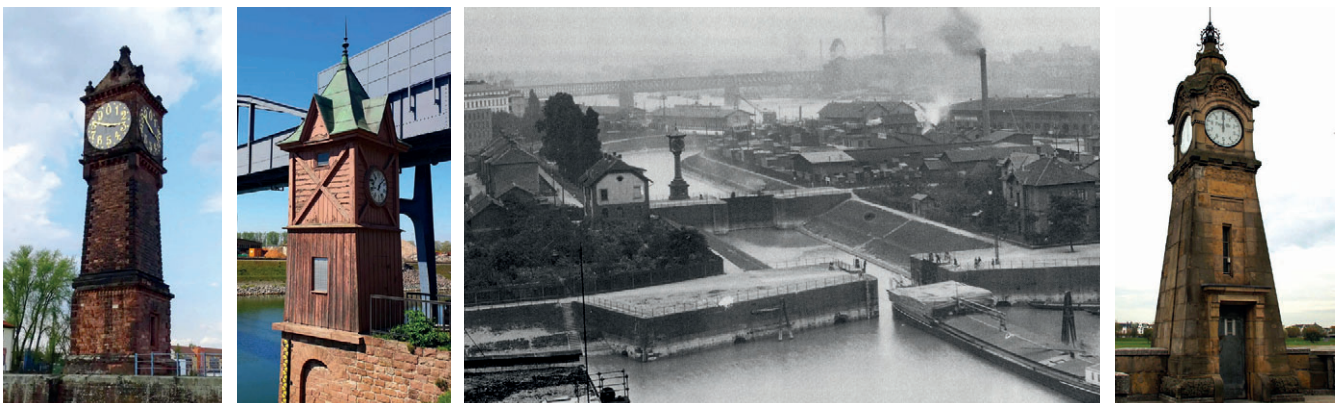
Obr. 17 Původní limnigrafy s ciferníkem kolem Rýna (tzv. „Pegeluhr“) měla města Ludwigshafen, Mannheim-Rheinau, Mannheim (zanikl) a Düsseldorf. Postaveny byly většinou kolem r. 1900.
