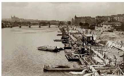
Obr. 8 Výstavba Podskalského nábřeží asi v r. 1906. Zdroj: Bečková (2012).
