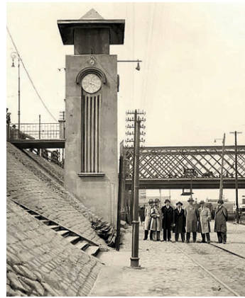
Obr. 18 Limnigraf ve Varšavě v r. 1938. Zdroj: M. Woznicki, 2013.
