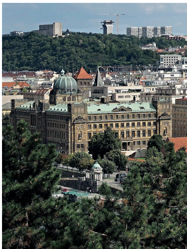
Obr. 19 Nábřeží Na Františku s budovou Ministerstva průmyslu a obchodu a limnigrafem. Foto: R. Tydlitát.
